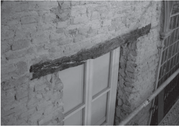
Fig. 1: Fábrica original de ladrillado del patio (Robador González, 2006: 24).
