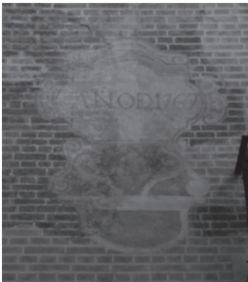
Fig. 3: Cartela I de la reforma del siglo XVIII en la fachada principal del edificio. Visible el término Año de 1767 , prueba de la reforma citada. Visibles también los colores que pudieron ser parte de la moda decorativa sevillana en el siglo XVIII: ocres-anaranjados (Imagen de elaboración propia).
